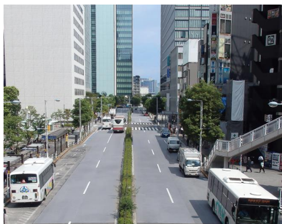
道路用遮熱塗料『ATTSU-9』が舗装された JR 品川駅東口周辺
